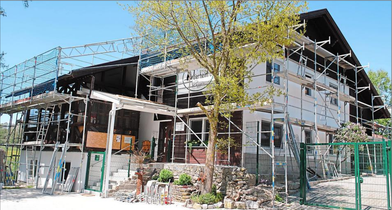
Das Gerüst am Tierheim steht. Damit kann mit dem Abtragen des Dachstuhls begonnen werden.
